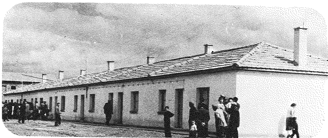
EN EL MADRILEÑO PUEBLO DE VALDETORRES DE JARAMA SE CONSTRUYERON 32 VIVIENDAS UNIFAMILIARES
